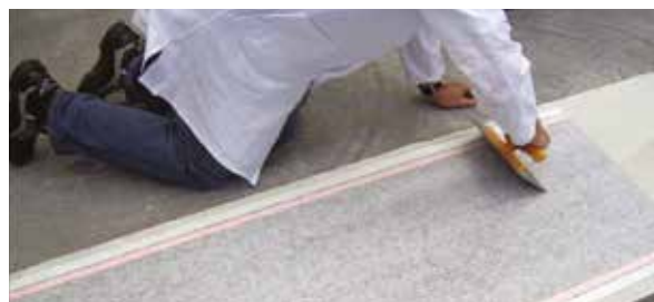
Abb. 7 Die Heizbahn wird im Kleberbett angedrückt
