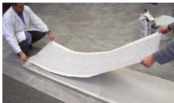
Abb. 6 Die Heizbahn wird in das frische Kleberbett eingelegt
